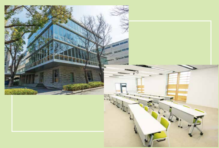
1号館ラーニングcommons
