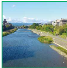
歴史・景観に配慮した河川整備
