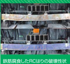
鉄筋腐食したRCはりの破壊性状
