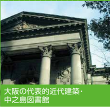
大阪の代表的近代建築・中之島図書館
