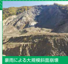
豪雨による大規模斜面崩壊
