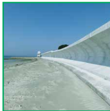
減災効果の高い 鋼・コンクリート合成護岸
