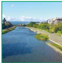
歴史・景観に配慮した河川整備
