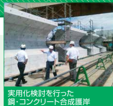
実用化検討を行った 鋼・コンクリート合成護岸
