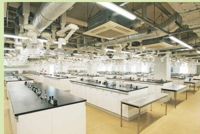
第2実験棟実験場
